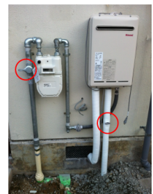
ガス栓：ガス管と平行が「開」
